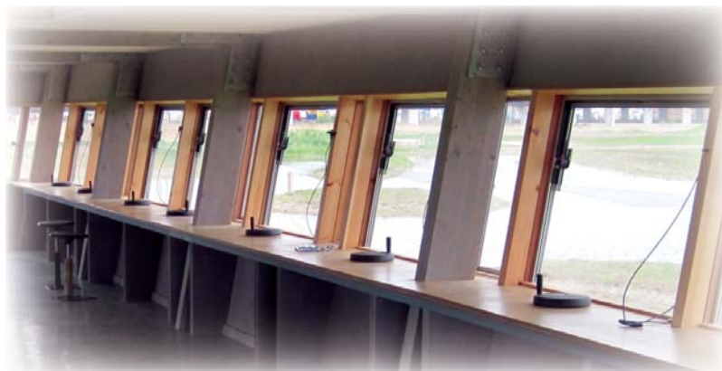
Внутренний интерьер наблюдательной станции. На подоконнике видны ручки лебедек, используемых для спуска и подъема и сдвижной панели
